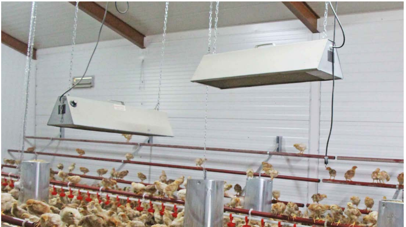
Gasstrahler Propan 5000 W regelbar Radiant au propane 5000W réglable
