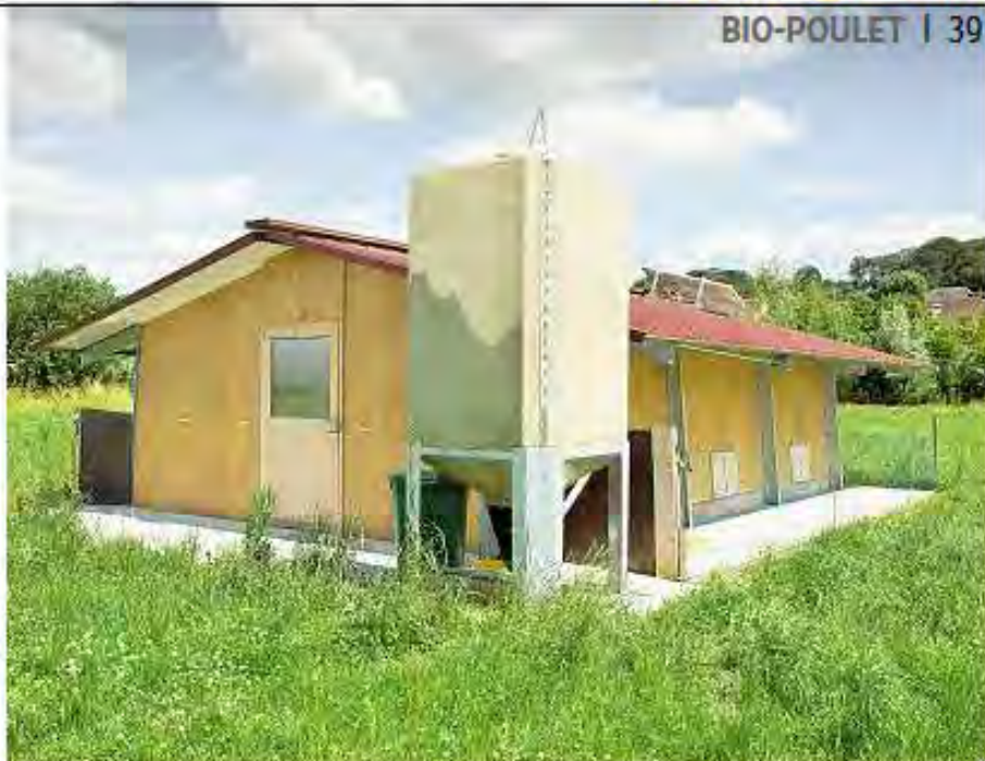
Das Trockenfutter wird vom aussen angebrachten Silo der Modellstallung automatisch in die Futterkrippen transportiert. Die Siloanlage wird mit Solarstrom betrieben.
